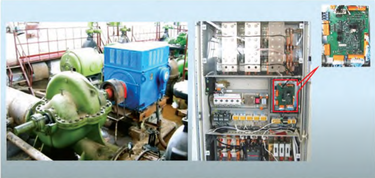
Регульований електропривід насоса потужністю 750 кВт на основі машини подвійного живлення
