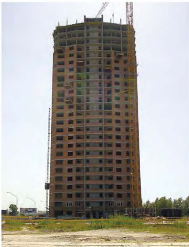
27-поверховий житловий будинок по Оболонському проспекту в м. Києві з системою віброізоляції (розташованого за 100 м від лінії метрополітену мілкого закладення)
