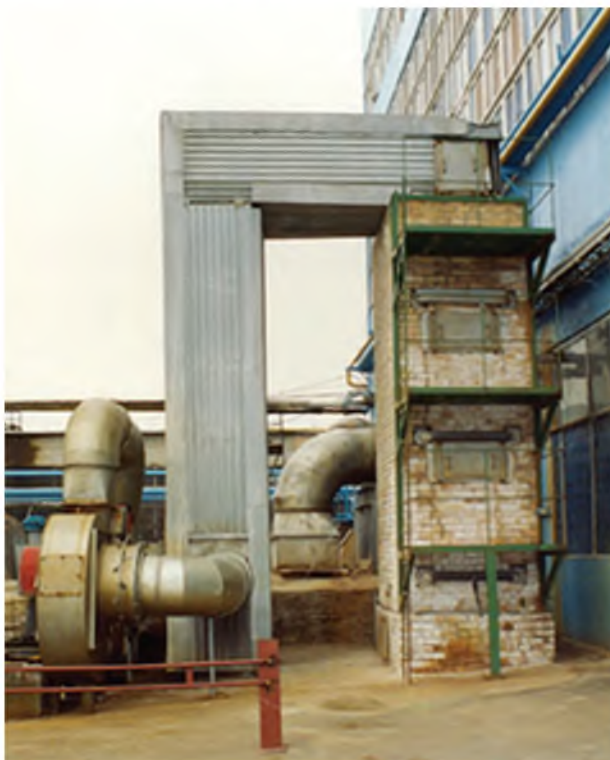
Теплоутилізаційна установка з теплоутилізатором ТВМ-20 за пічню № 3 Гостомельського склозаводу (Київська обл.)
