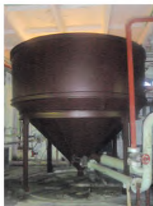
Антикорозійний захист внутрішньої і зовнішньої поверхонь: трубопроводів обв'язки фільтра (ліворуч), ємкості Н-катионітового фільтра (у середині), ємкості бака зм'якшеної води (праворуч)
