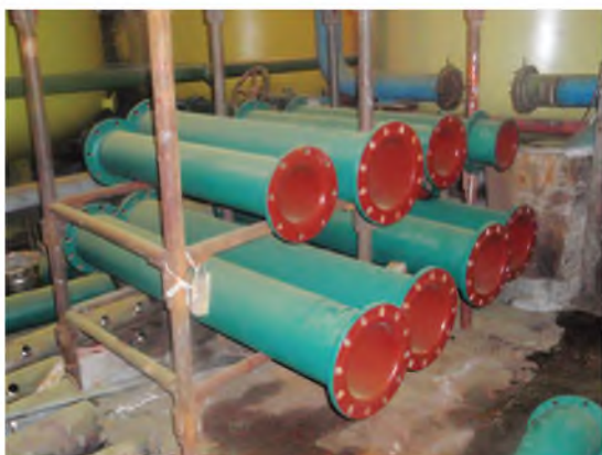
Антикорозійний захист внутрішньої і зовнішньої поверхонь: трубопроводів обв'язки фільтра (ліворуч), ємкості Н-катионітового фільтра (у середині), ємкості бака зм'якшеної води (праворуч)
