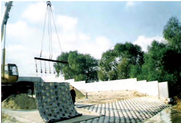
Процес улаштування гнучкого кріплення
