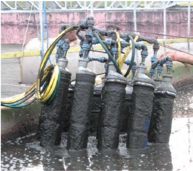
Фільтрувальний модуль в аеробному стабілізаторі БСА
